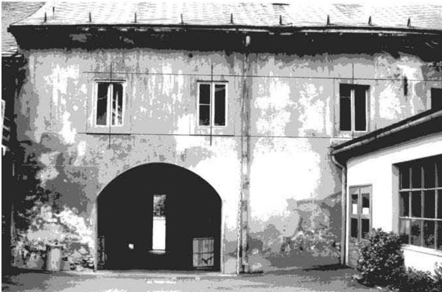
**Bild 2.3.1.4** Fassadenaufnahme mit Vergleichsmaßstab (Geometerstab senkrecht)
