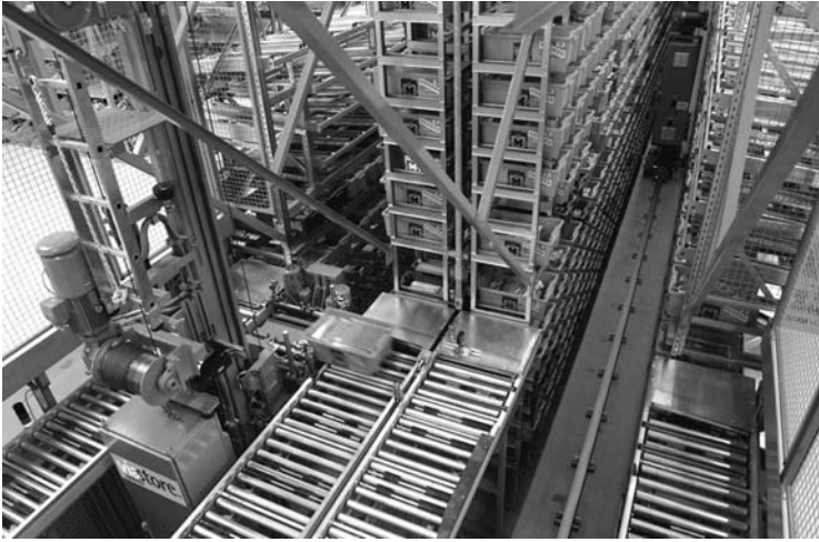
Automatisches Kleinteilelager [Quelle: VIASTORE]
