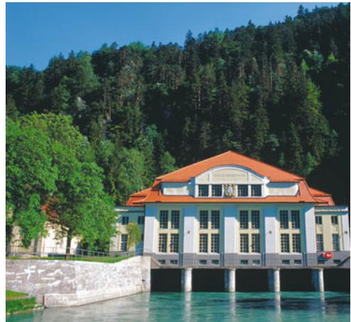
**Bild 4:** Wasserkraftwerk der DB Energie AG in Bad Reichenhall, erbaut von 1910 bis 1913 (5 horizontale Francis-Kessel-Turbinen mit insg. 5,2 MW, Jahresarbeit 40 Mio. kWh/a)
