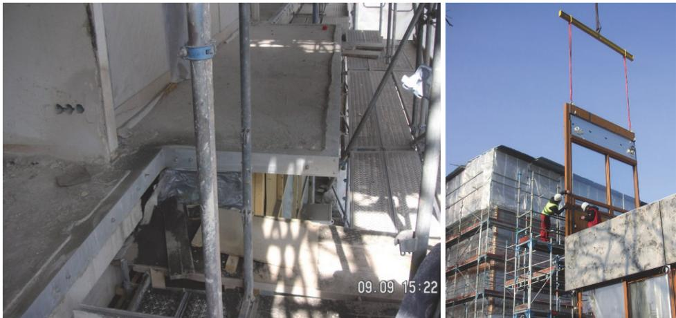
Abbildung 5: links: Angepaßte Deckenränder mit Stahleinfassung; rechts: Fassadeneinbau (Fotos: Staatliches Hochbauamt Karlsruhe)
