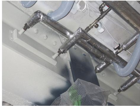
Abbildung 6: links: Vorbelastete Deckenränder (Foto: Stephan Baumann); rechts: Warmwasserbeheizte Fassadendurchdringungen der Stahlträger (Foto: Staatliches Hochbauamt Karlsruhe)
