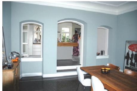
Abbildung 8: Die Küche sitzt zwei Stufen erhaben über dem Essbereich und ist durch eine Wand mit drei Öffnungen abgeteilt. Die Leitungen in der Küchenzeile versorgen auch das Bad direkt darüber (Fotos: Oehler)
