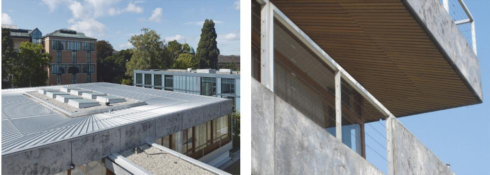
Abbildung 7: links: Aluminiumstehfalzdächer mit konischer Scharenausbildung (Foto: Stephan Baumann); rechts: Eckausbildung der Holzverschalten Deckenuntersichten (Fotos: Stephan Baumann)
