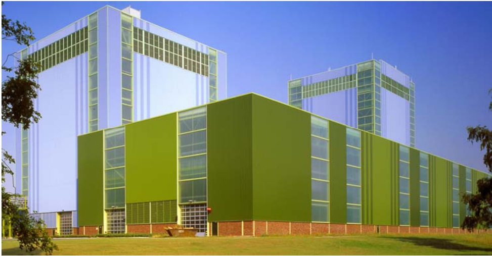
Bild 2-2b Fassade der Feuerverzinkungsanlage FBA 8 in Dortmund
