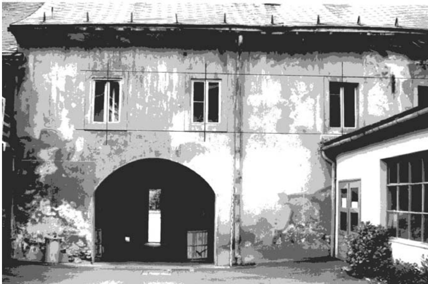
Bild 2.3.1.4 Fassadenaufnahme mit Vergleichsmaßstab (Geometerstab senkrecht)
