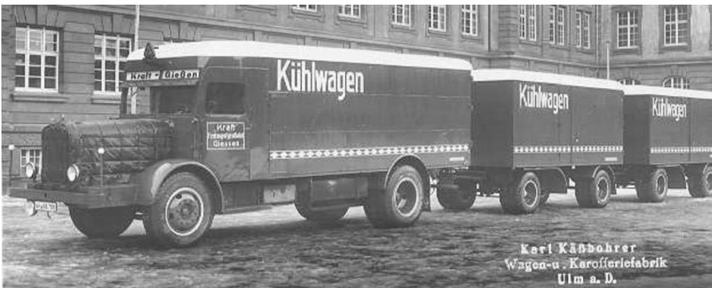
**Bild 1-3** Untermotorisierter Lastzug 1936 von Henschel/Kässbohrer mit 125-PS-Dieselmotor, 34 t Gesamtgewicht (3,7 PS/t) (Karl Kässbohrer GmbH)
