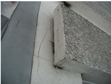
Abb. 2.2.2-1 Profilierte Balkonbrüstung aus Beton
