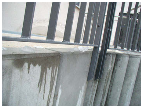
Abb. 2.1.2-4 Unkontrolliertes Wasserablaufen
