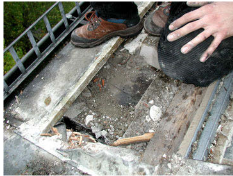
Abb. 2.1.4-2 Geöffnetes Dach oberhalb der Zimmerdecke
